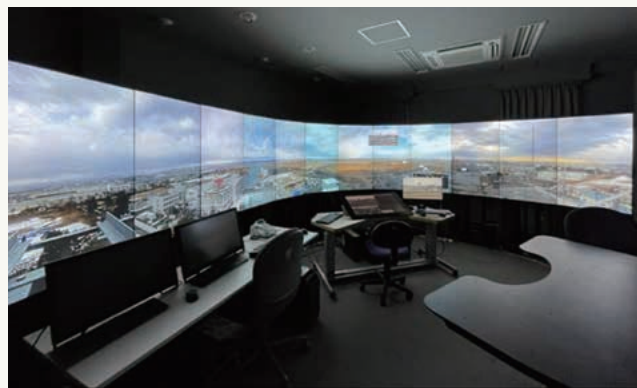
図2. RT・DT評価用試作システム(制御室)
