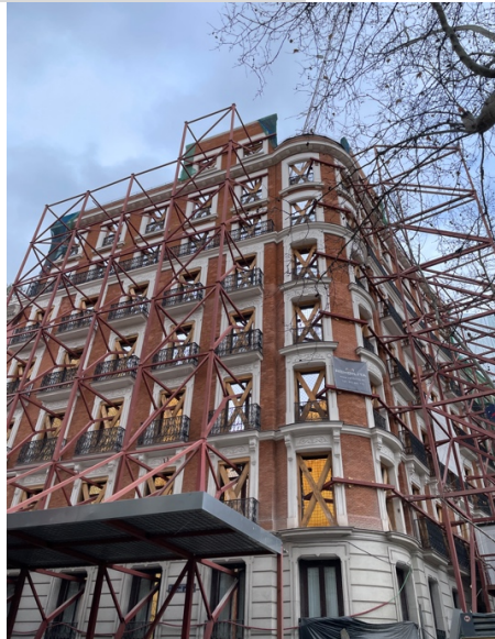
建築の改修工事中、外壁だけ保存してある
