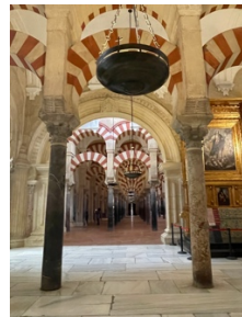
増築された部分
